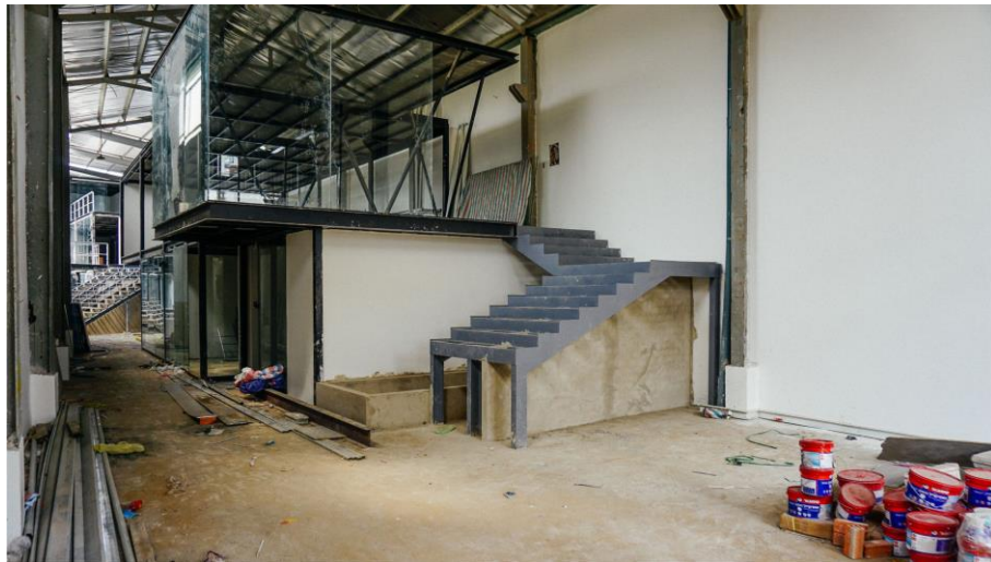
Hình 1.2 Hiện trạng xây dựng công trình
